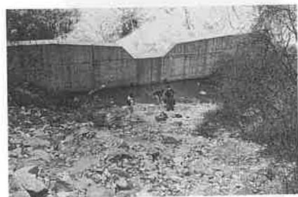
図3-3 ズリ堆積場と砂防ダム
