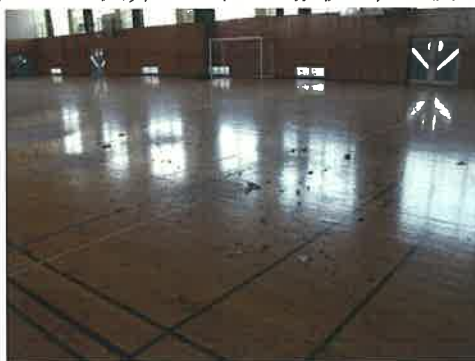
④体育館 天井のパネルが数枚が、破損し落下した。天井に隙間ができた。
