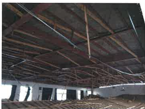
特別教室棟 2階廊下天井給水管破断による漏水，音楽室・視聴覚室天井落下 卓球場 天井全面落下，外壁面の崩落
