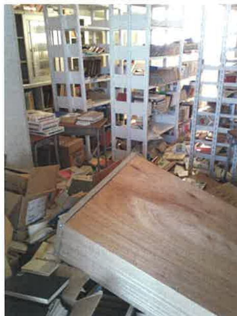
棚自体も倒れたりスライドしたりした。
