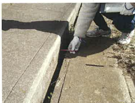
校舎基礎部分と側溝の隙間
