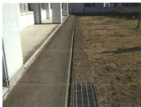
校舎基礎部分と側溝の隙間
