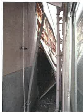
体育館 ステージ天井のコンパネ落下，内壁破損，照明破損，外壁落下
