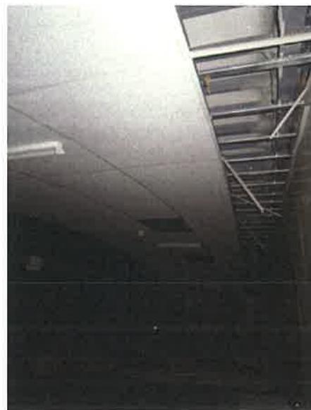
体育館ステージ天井
