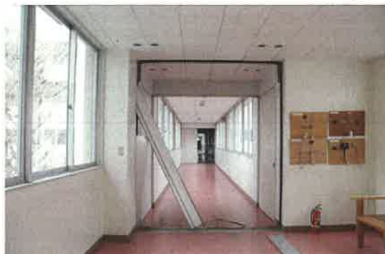
写真 11 電子機械科棟から特別教室棟に 続く渡り廊下（2階）
