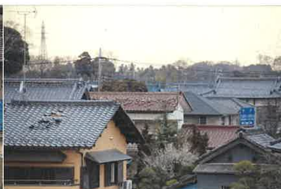
写真 20 学校周辺の家屋の被害状況 (その 2)
