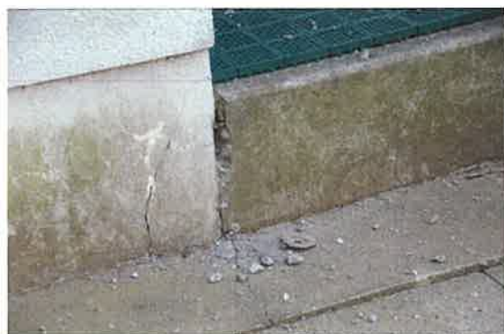
写真 17 たたきの継ぎ目の一部が破損
