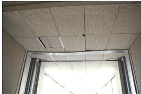
2F 連絡通路 接合部
