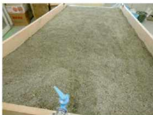
写真③ 全体に左官砂を敷いた様子
