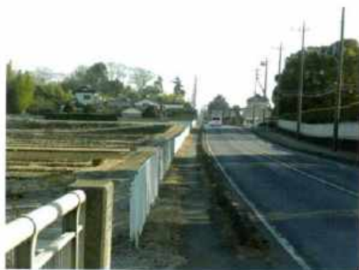
写真⑤磯川の橋から积水西排水路を望む
