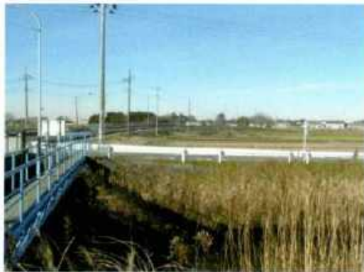
写真④磯川の橋から女沼川を望む
