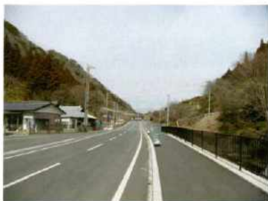
① 国道461号線坂下付近北方向
