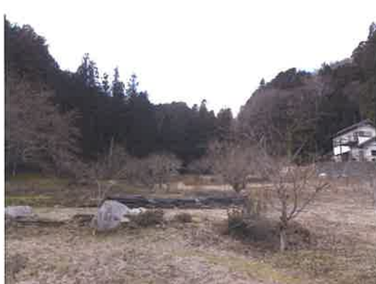
写真4 扇頂付近の様子
